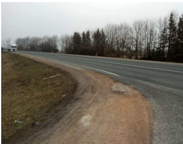
15.attēls. Detālplānojuma teritorijas pievienojums valsts galvenajam autoceļam A7 – skats uz Rīgas pusi.
