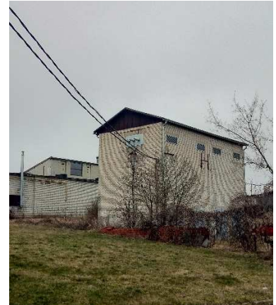
9. attēls. 20/0.4. kV transformatora apakšstacija.
