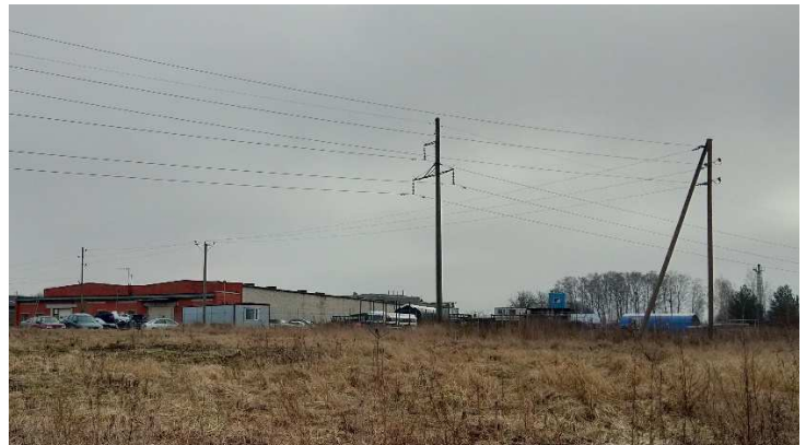
11.attēls. Skats no neapbūvētas teritorijas uz 110kV un 20kV elektroliņijām.
